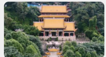
宜宾市翠屏山游客中心智慧能源管理系统
