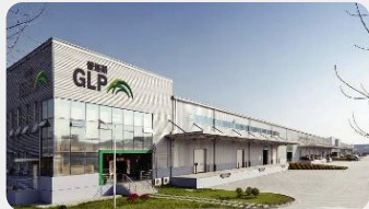
普洛斯智慧园区安全用电管理系统
